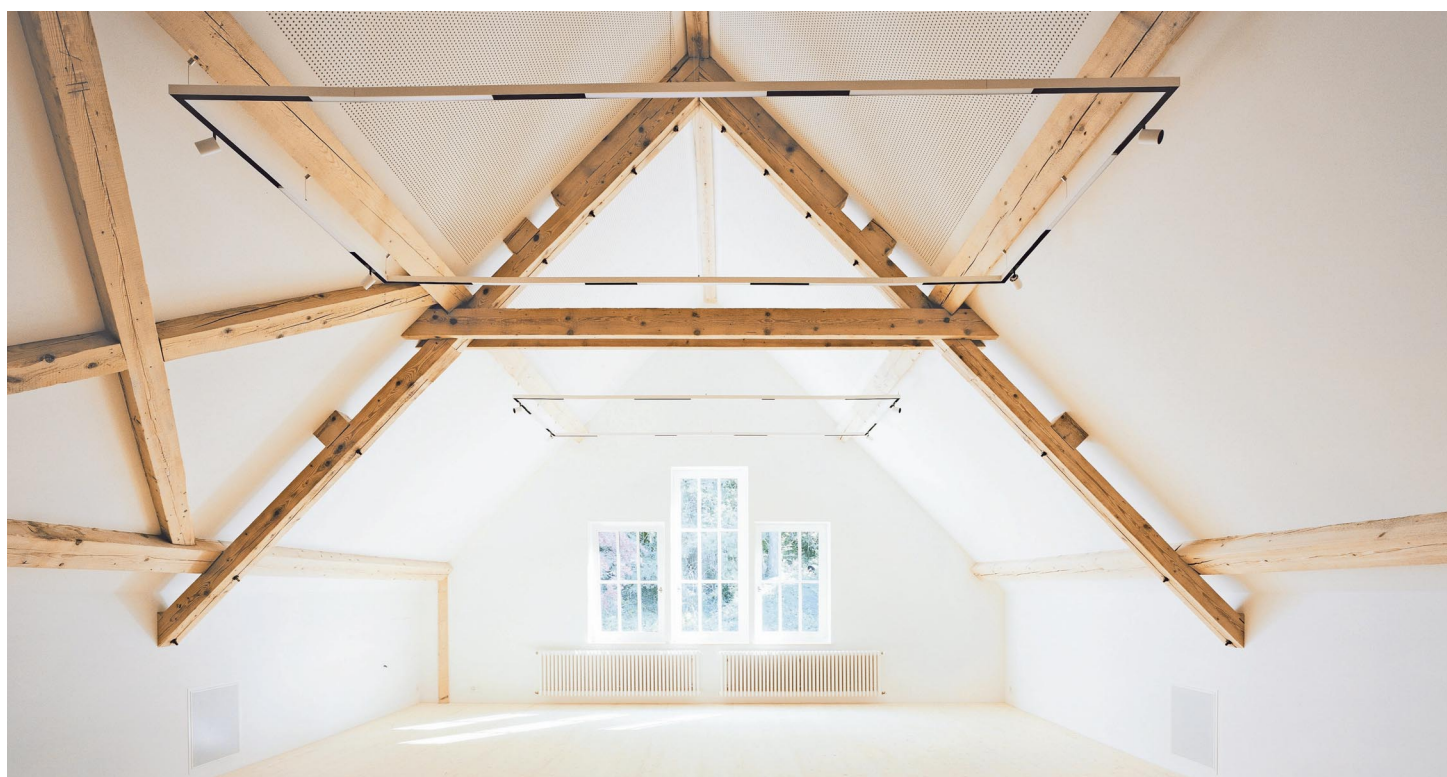
Die historische Konstruktion des Dachstuhls ist nach der Freilegung wieder sichtbar.
