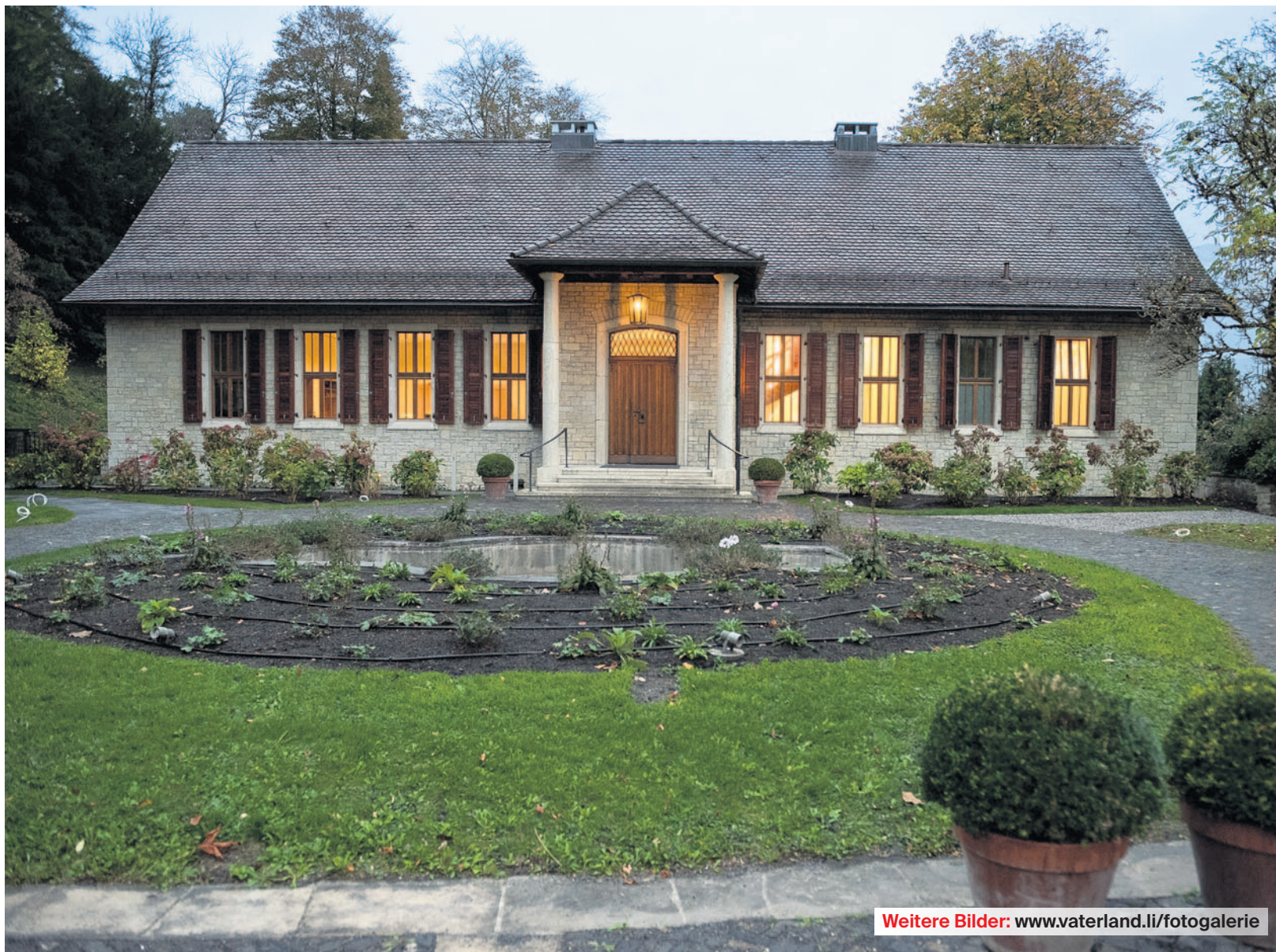
Das Anwesen Stein Egerta wurde mit 6,8 Millionen Franken über drei Jahre hinweg umfangreich renoviert.
