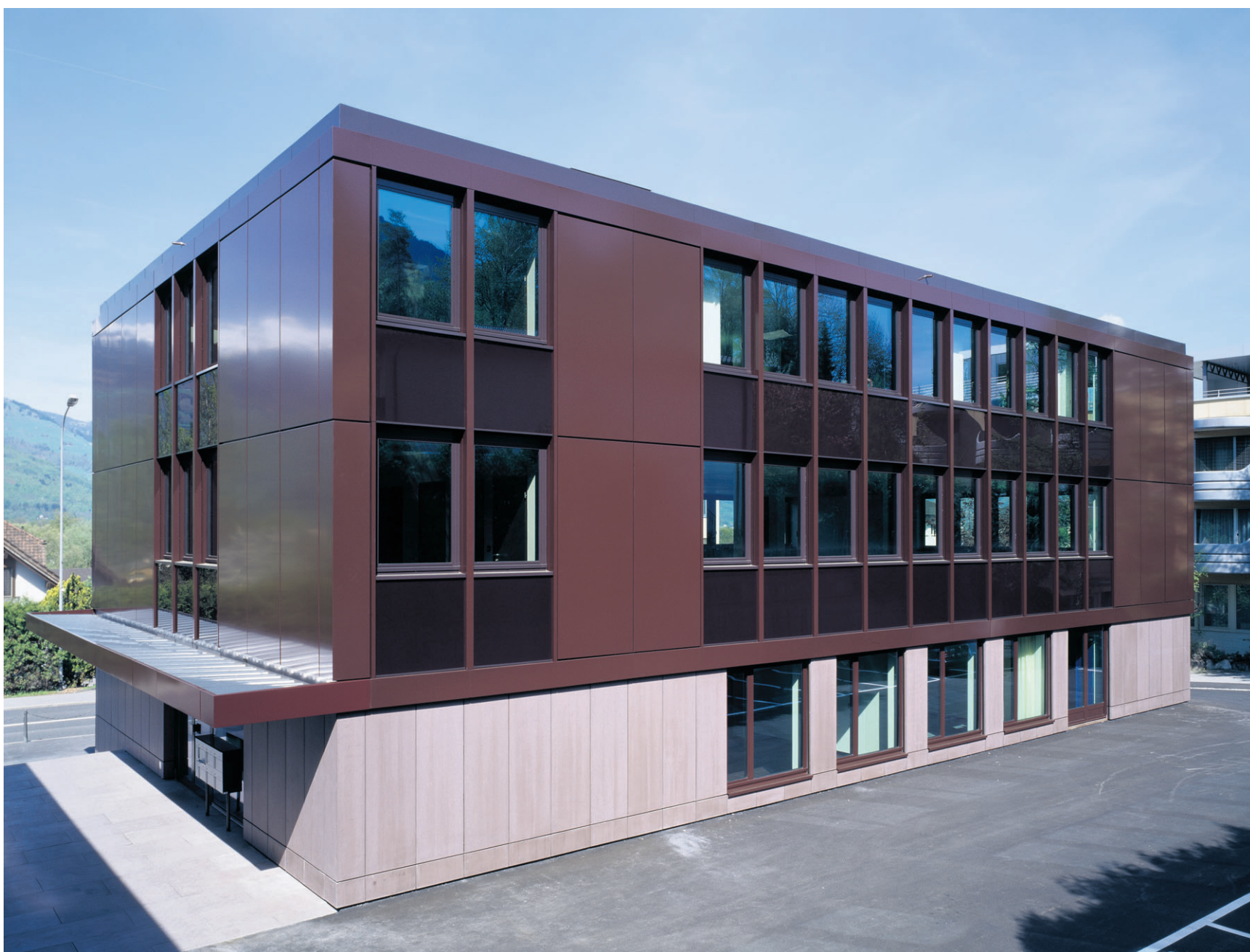
Markantes Gewand: Baukörper und Fassade sollen Identität stiften und sich dennoch in die Umgebung einfügen.
